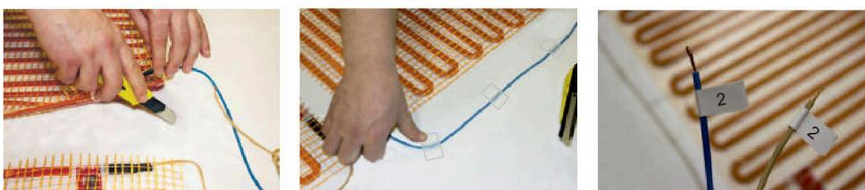
**Важно!** Избегайте возникновения воздушных щелей и зазоров между нагревательным матом и полом во время его укладки в kleящий раствор.
